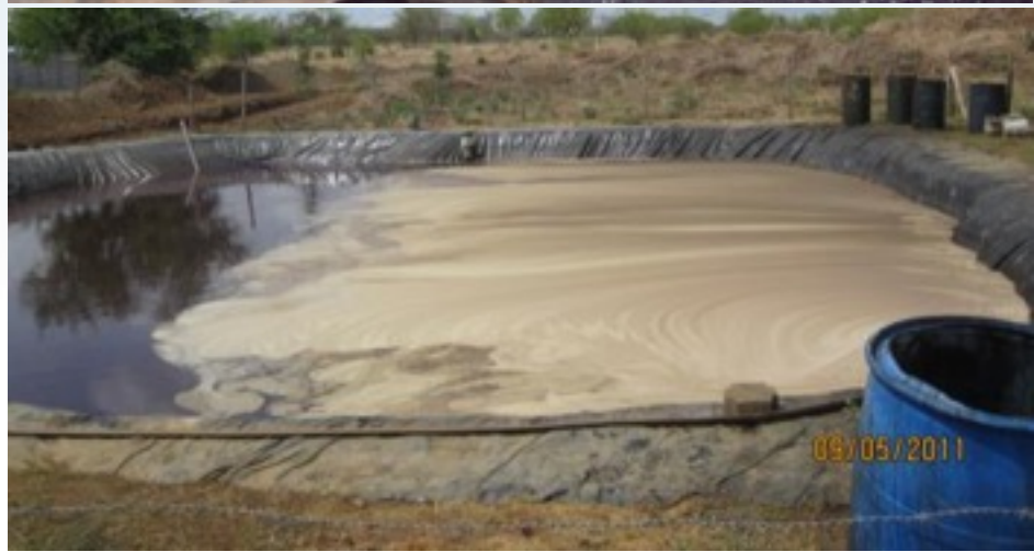
Laguna de tratamiento previo a la construcción de biodigestor
