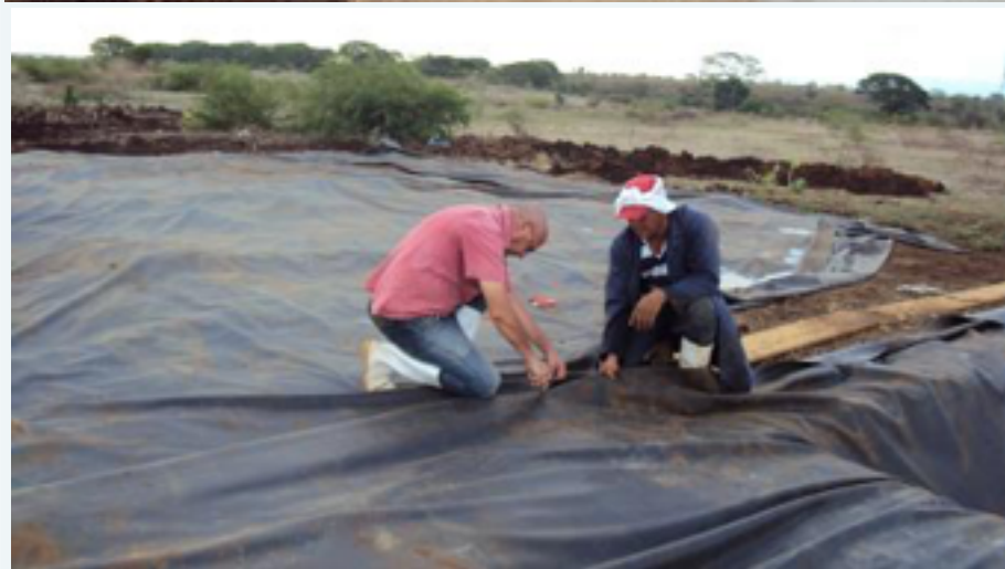
Corte membranas
