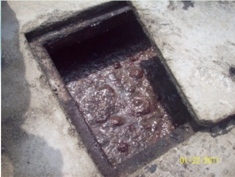
Tanque de sedimentación existentes previo a la construcción del BD
