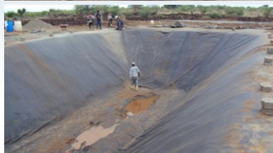
Laguna revestida con membrana
