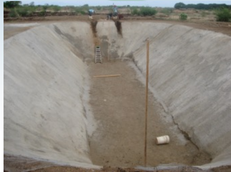
Estabilización de taludes
