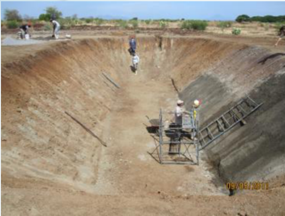
Construcción de laguna para biodigestor
